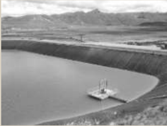
Detalle del depósito de relaves 4, se puede apreciar la geomembrana instalada y la zona de bombeo hacia la operación de beneficio
